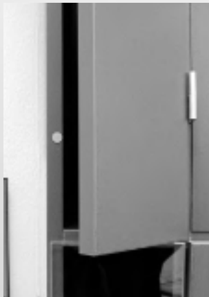
Magnetverschluß INN ohne Polschuhe in Holzschrank
