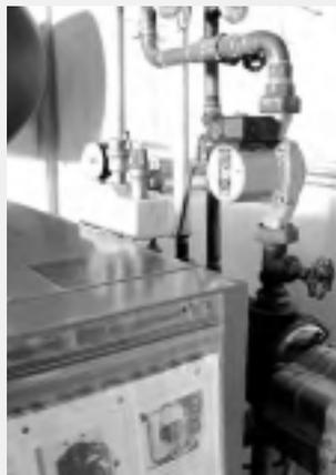
Heizungsgehäuse mit Magnetverschluss
